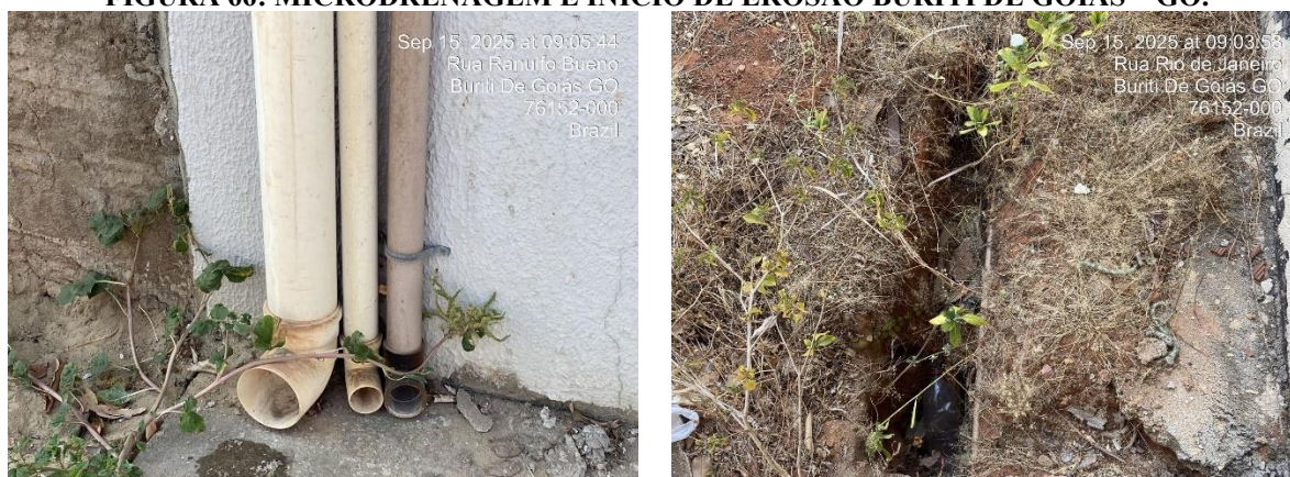
FIGURA 66: MICRODRENAGEM E INÍCIO DE EROÇÃO BURITI DE GOIÁS – GO.
