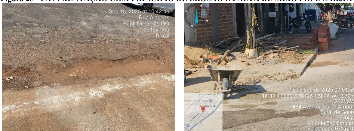
Figura 25 - PAVIMENTAÇÃO COM PRINCÍPIO DE EROSÃO E FALTA DE MEIO FIO E SARJETA
