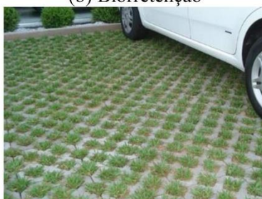
(e) Pavimento permeável Fonte: TASSI, et al. (2016)
