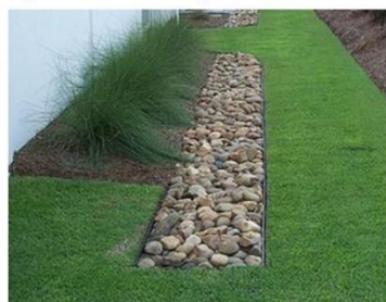
(a) Trincheira de infiltração
