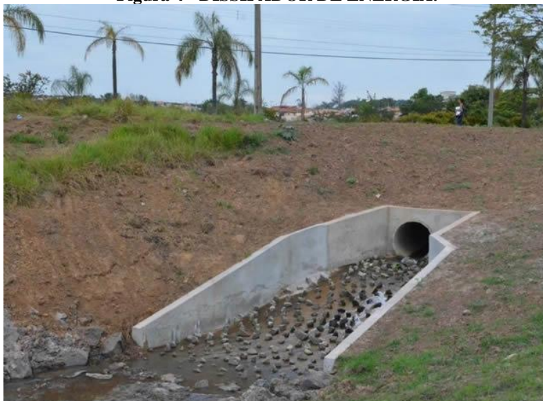
Figura 4 - DISSIPADOR DE ENERGIA.
